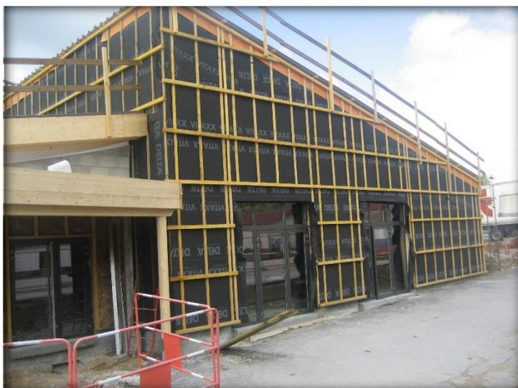
Photos prises le 2 mai 2018 : l'isolant est recouvert par un bardage.
